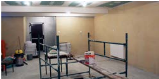
Remont remizy OSP w Łabowej
