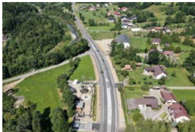
Skrzyżowanie drogi krajowej nr 75 z drogą powiatową Maciejowa-Barnowiec po przebudowie foto. Andrzej Klimkowski
