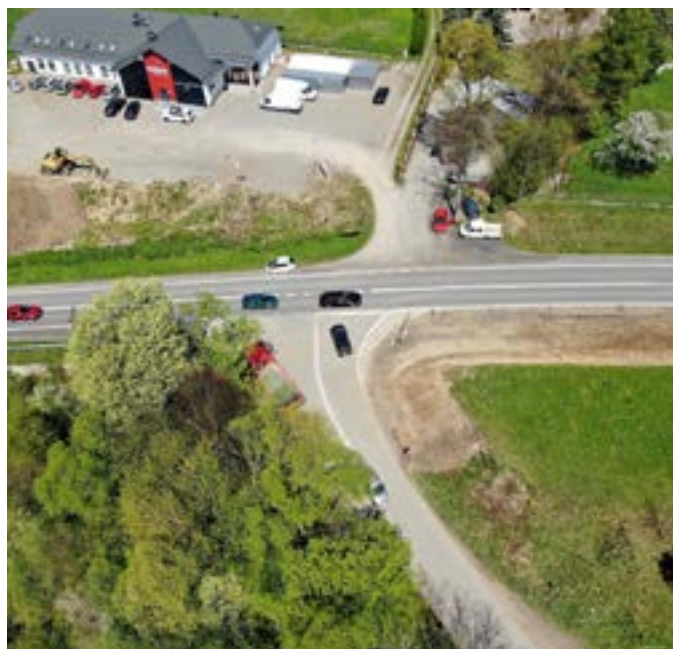
Niebezpieczne skrzyżowanie przed przebudową foto. Andrzej Klimkowski
