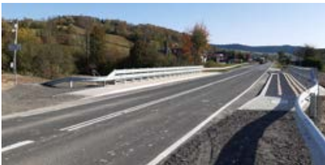
Wyremontowany most w Nowej Wsi
