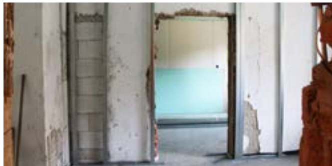
Remont remizy OSP w Łosiu
