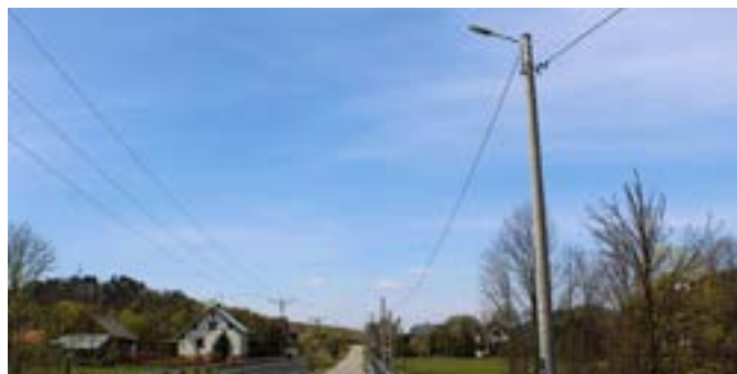
Oświetlenie w ciągu drogi gminnej Łabowa - Feleczyn
