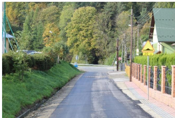
Fot. 26. Modernizacja drogi gminnej - osiedlowej w Nowej Wsi (po).
