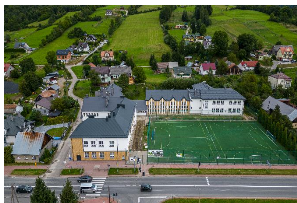
Fot.10 Termomodernizacja Szkoły Podstawowej w Łabowej (po)
