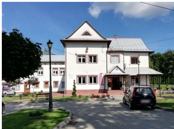
Fot. 11. Termomodernizacja budynku Urzędu Gminy w Łabowej (przed).
