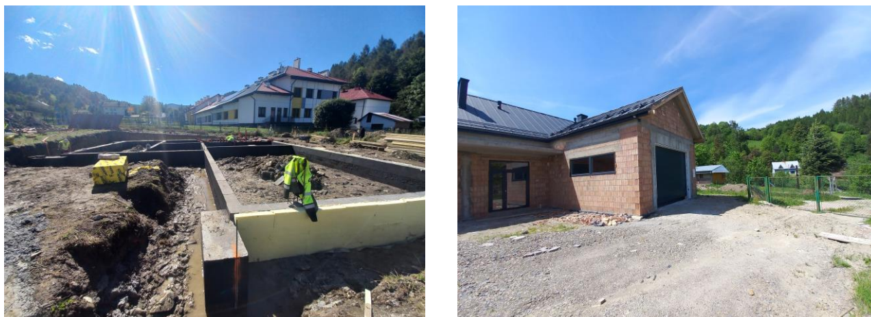
Fot. 4 Remiza OSP w Czaczowie w budowie
