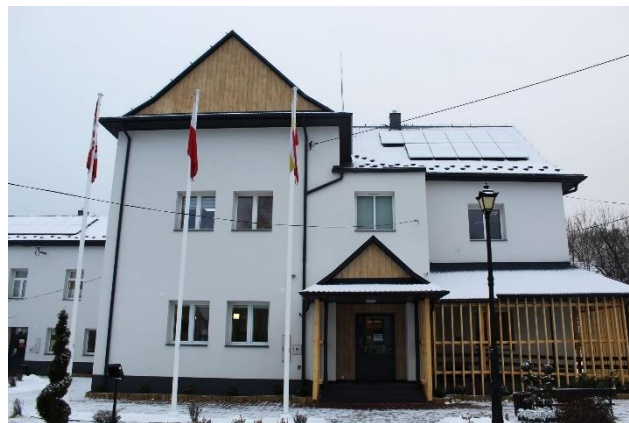
Fot. 12. Termomodernizacja budynku Urzędu Gminy w Łabowej (po).
