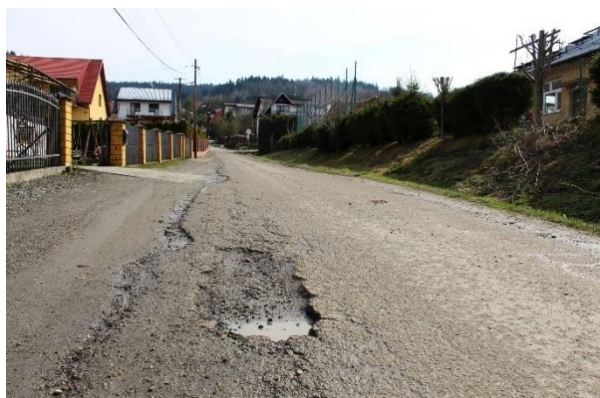
Fot. 25. Modernizacja drogi gminnej - osiedlowej w Nowej Wsi (przed).
