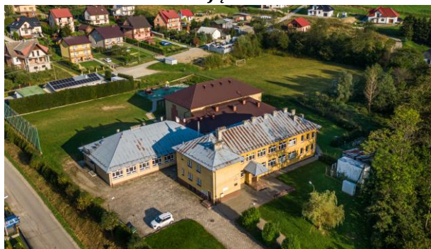
Fot. 17 Szkoła Podstawowa w Nowej Wsi Przed termomodernizacją
