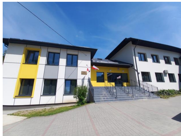
Fot. 2. Termomodernizacja Szkoły Podstawowej w Czaczowie (po).
